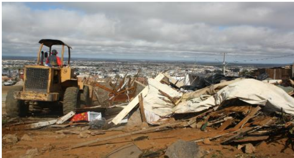
Figura 9 – Barracos sendo demolidos no bairro Nova Cidade
