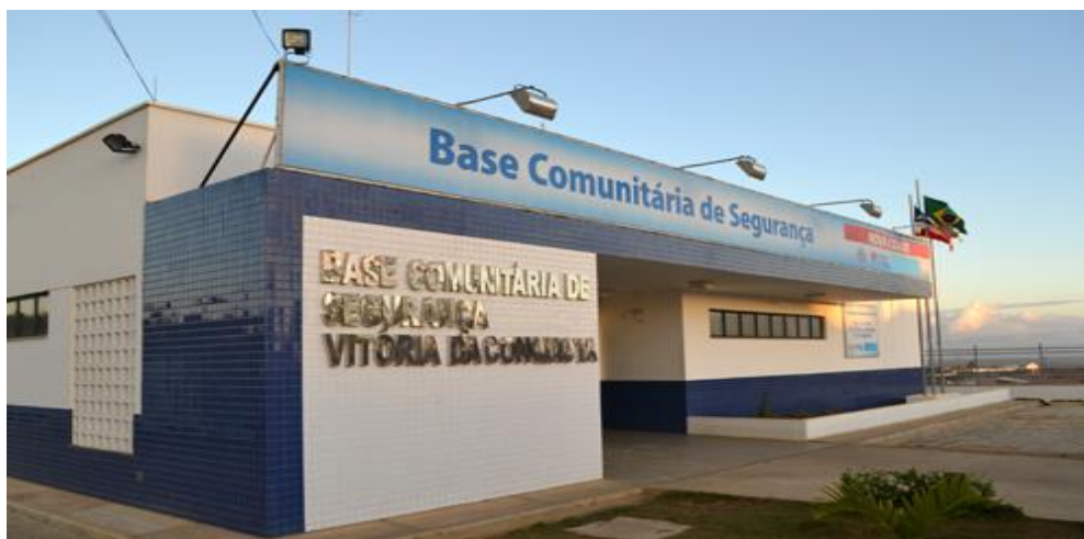
Figura 1 – Sede da BCS/Nova Cidade
